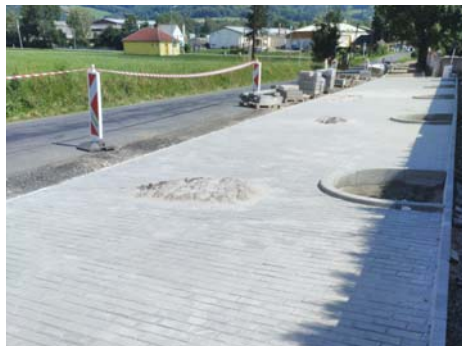
Oprava chodníku u hřbitova
