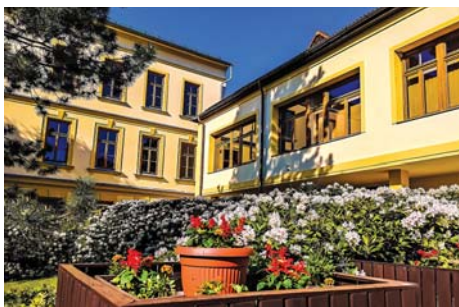
Po rozsáhlých externích rekonstrukcích školy v minulých letech se v současnosti inovace přesouvají do interiérů, autor Jiří Ševčík
