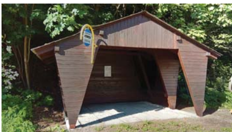
Opravená zastávka v Horním Bohdíkově a Žárová most
