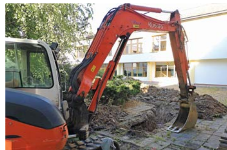
Pokládka nové plynové přípojky k paralelní kotelně v pavilonu tělocvičen, autor Jiří Ševčík
