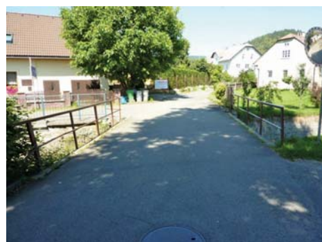
Most ev. č. 20c – M1 na ul. Žižkova
